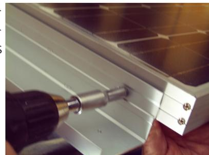
Wenn Sie beide Montageschienen am Modul befestigt haben, legen sie das Modul mit Montageschienen an die Stelle, die Sie zuvor mit Hilfe der Schablone bestimmt haben und markieren Sie diese Stelle. Bei einer Montage von mehreren Modulen sollte darauf geachtet werden, dass das Modul, an dem das lange Kabel befestigt ist (zweites Modul), sich in unmittelbarer Nähe zur vorgesehenen Dachdurchführung befindet.
