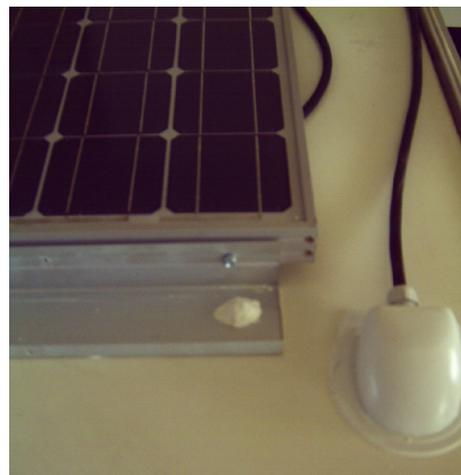
Im Anschluss muss die Kunststoffabdeckung (Spoiler) an der Modulhalterung angebracht werden. Das Befestigen der Kunststoffabdeckung auf den Aluminiumschienen erfolgt mittels der mitgelieferten Kunststoffnieten.
