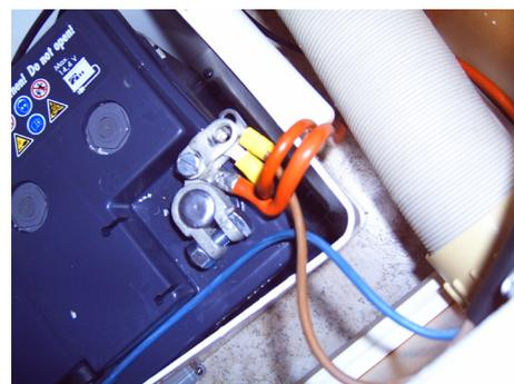
Verdrahten Sie nun den Laderegler „Symbol Batterie +“ mit dem Pluspol der Batterie und „Symbol Batterie -“ mit dem Minuspol der Batterie. Dabei sollten wieder die Hinweise zum Abisolieren unter Punkt 4 beachtet werden. Verwenden Sie hierfür Quetschkabelschuhe (bauseits), die mit Hilfe einer Crimpzange fest an die beiden Kabelenden angebracht werden müssen.
