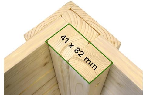
Extra stabile Verbindungen durch gedoppelte umlaufende Rahmung.
