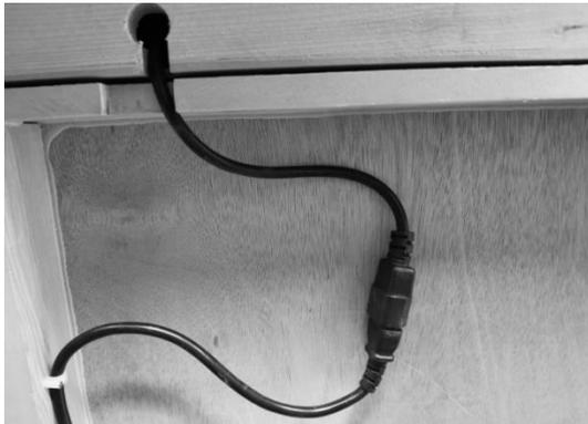
(1) Stecken Sie die Steckverbinder der Heizkabel ein, stellen Sie sicher, dass die Kabel nicht eingeklemmt Deckenpaneel und anderen Paneelen.
