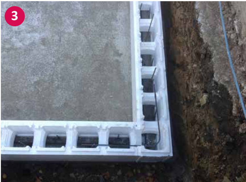
▲ Detailbild einer Eckverbindung samt Eisenarmierung
