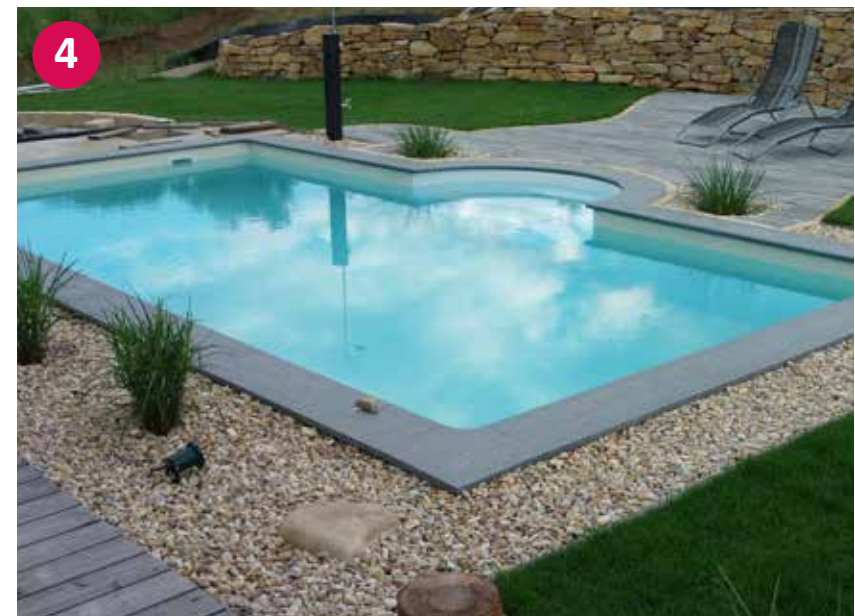
▲ Fertiges Styroporsteinbecken mit Römertreppe
