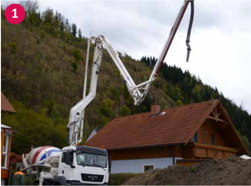
▲ Betonwagen mit Betonpumpe und Fallbremse
