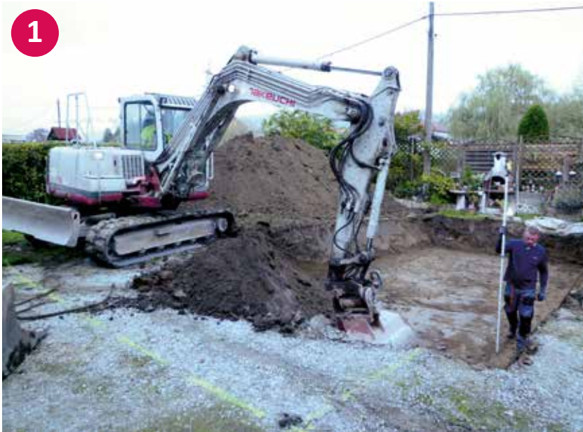
▲ Aushub der Baugrube
