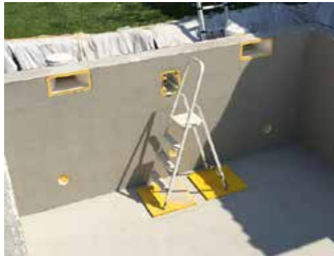
▲ Fertig verspachtelte Innenwand
