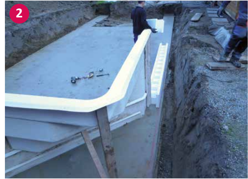
▲ Abstützen sowie senkrecht eund waagerechte Einrichtung der Ecktreppe
