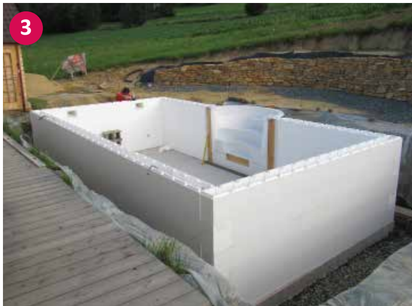
▲ Aufgestelltes Styroporstein Becken mit Römertreppe – ohne Betonfüllung
