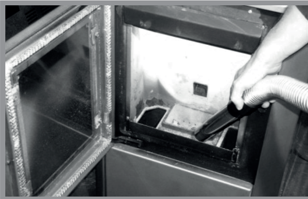
Abb. 12a: Reinigung des Brenntopfes
