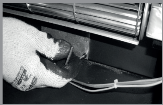
Abb. 13b: Aufschrauben der inneren Abdeckplatte
