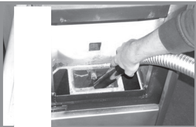
Abb. 12f: Reinigung Brennraumbehälter
