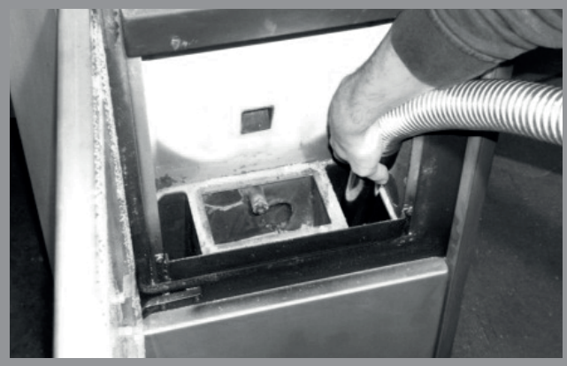
Abb. 12g: Reinigung untere Brennkammer
