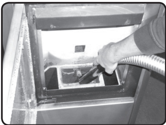
Abb. 14f: Reinigung Brennraumbehälter
