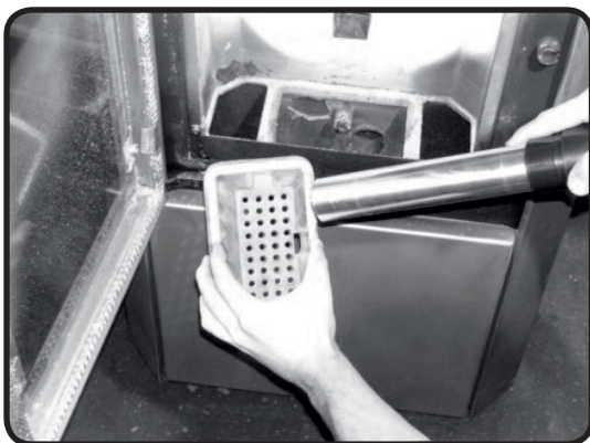
Abb. 14b: Reinigung der Luftöffnungen mit einem Staubsauger
