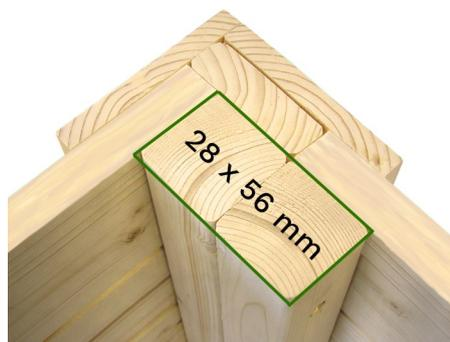
Extra stabile Verbindungen durch gedoppelte umlaufende Rahmung.
